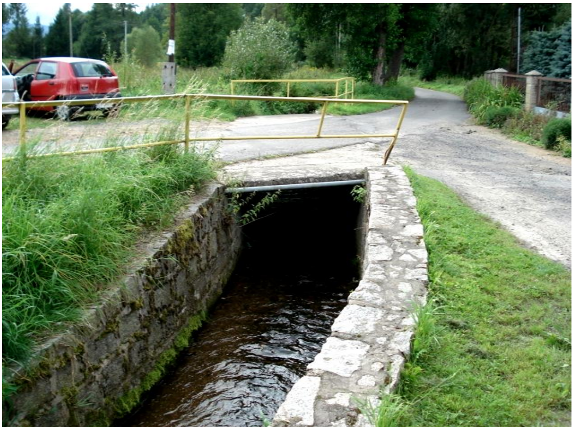
Fot. nr 6. Widok od górnej wody, urządzenie obce – sieć tel. w stalowej rurze ochronnej
