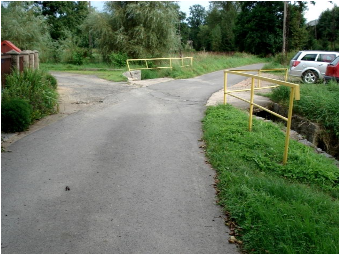
Fot. nr 1. Widok ogólny – układ komunikacyjny w obrębie mostu, wjazd drogi bocznej
