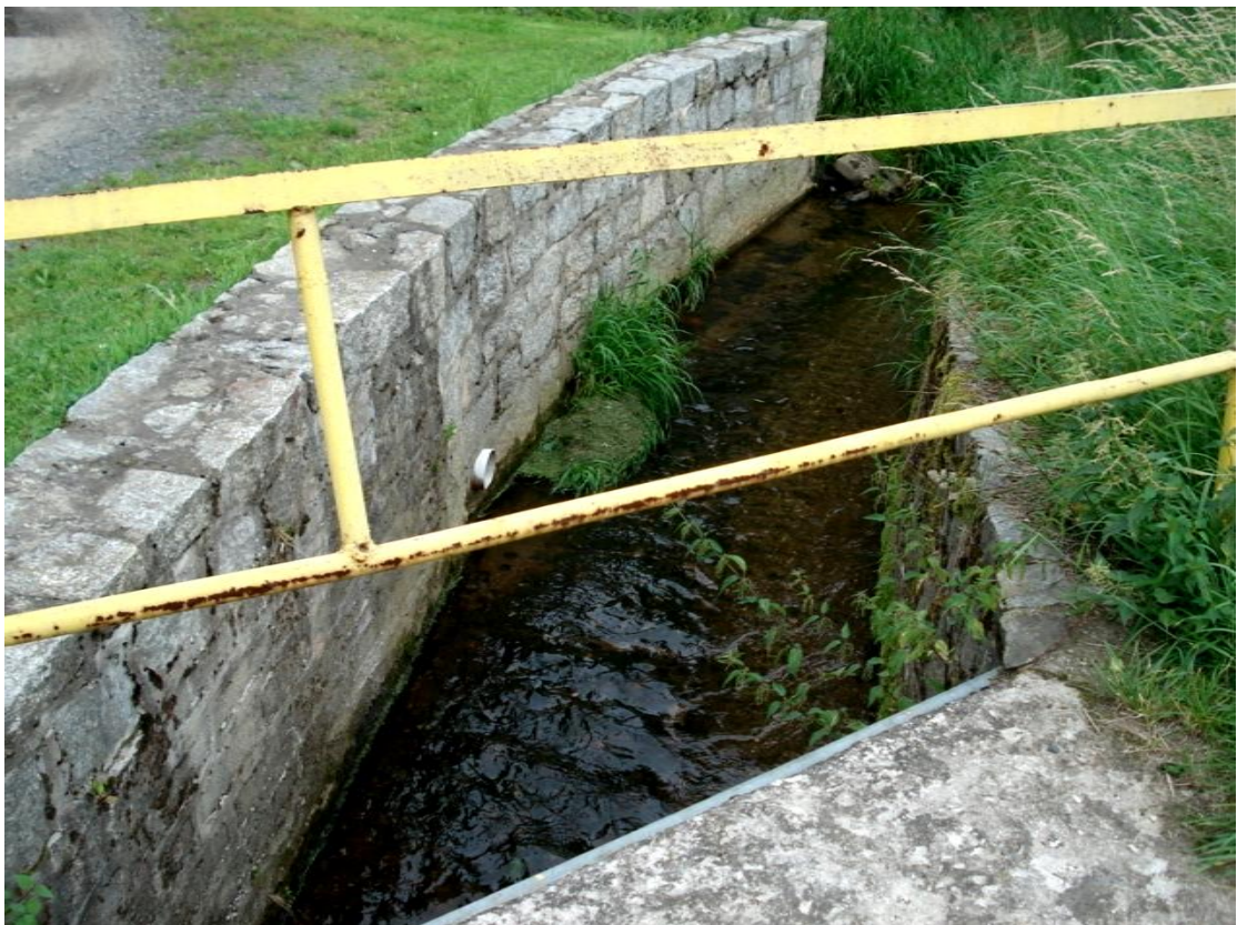
Fot. nr 8. Prawobrzeżny mur brzegowy od górnej wody.
