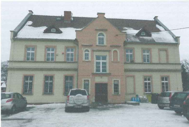
Fot. 1 – elewacja zachodnia istniejącego budynku szkoły
