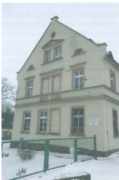
Fot. 3- elewacja południowa szkoły
