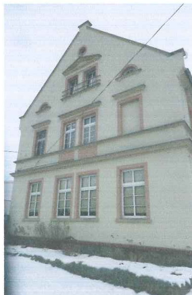
fot. 4 – elewacja północna szkoły
