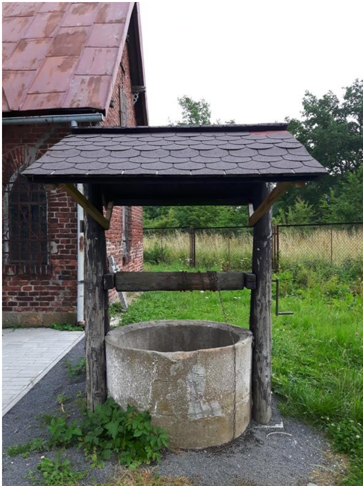
Fot. 7 Widok studni przy kapliczce – istniejące elementy zadaszenia do wyburzenia. Nowe zadaszenie wykonać na wzór istniejącego. Pokrycie zadaszenia winno nawiązywać do pokrycia dachu kapliczki. Krąg betonowy do obudowania kamieniem miękkim. Należy zachować funkcję czerpalna studni – winna zostać wyposażona w kołowrót oraz łańcuch wiadro stalowe ocynkowane umożliwiające czerpanie wody.
