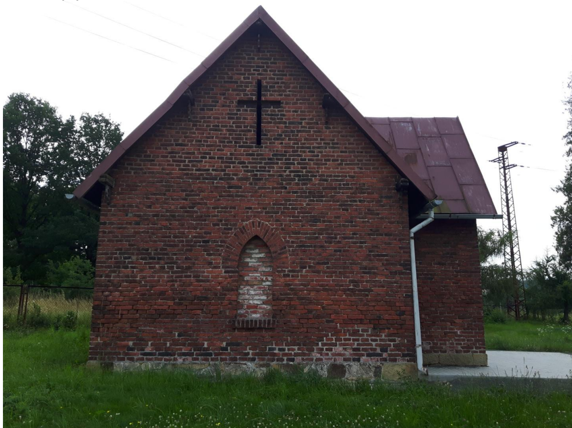
Fot. 2. Elewacja północna
