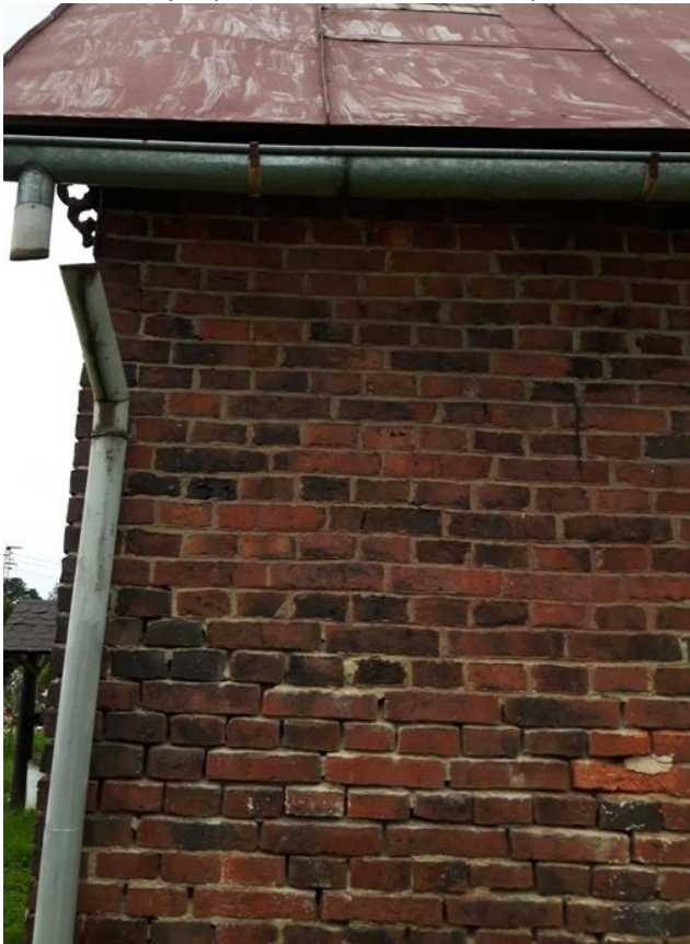
Fot.3. Elewacja tylna – widok na dach, orywnowanie oraz stan techniczny muru,
