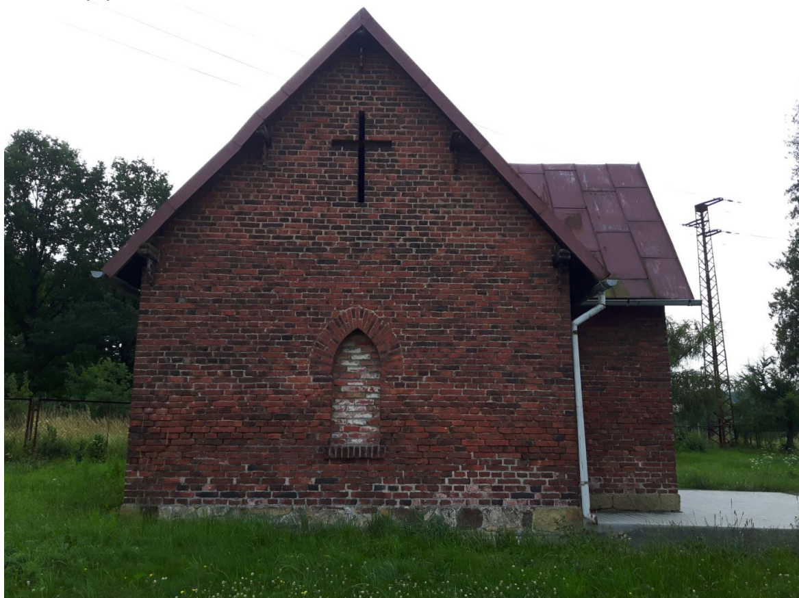
Fot. 2. Elewacja północna
