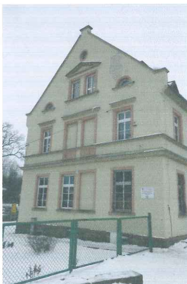
Fot. 3- elewacja południowa szkoły
