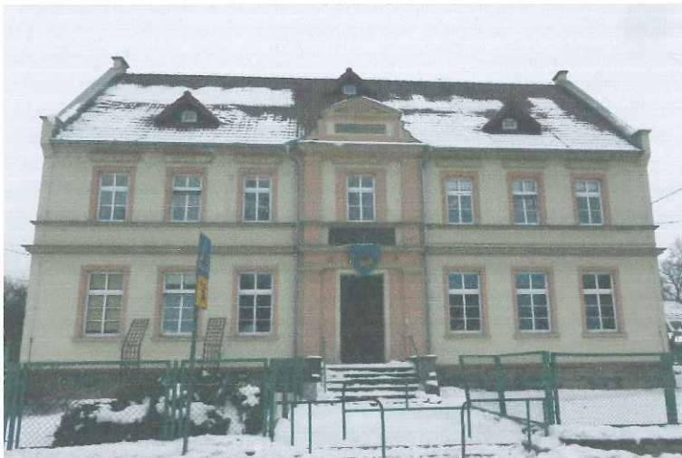
Fot. 2 – elewacja wschodnia istniejącego budynku szkoły
