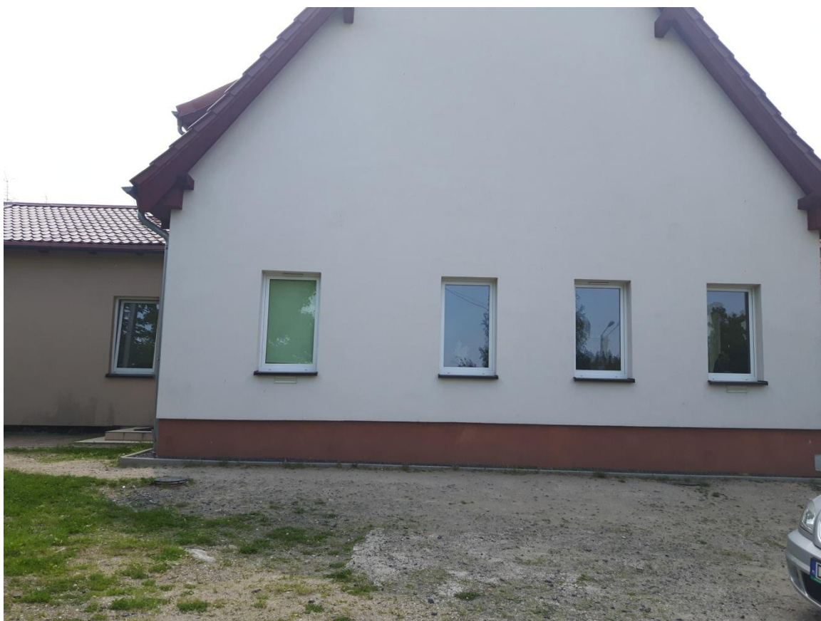
Zdjęcie nr 2 – widok na szatnię – planowane wejście na halę w okolicach 2 i 3 okna
