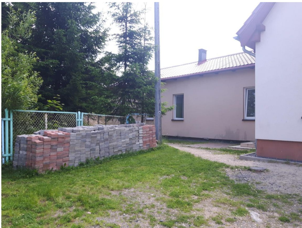
Zdjęcie nr 4 – widok na ciąg komunikacyjny w kierunku kompleksu rekreacyjno – sportowego
