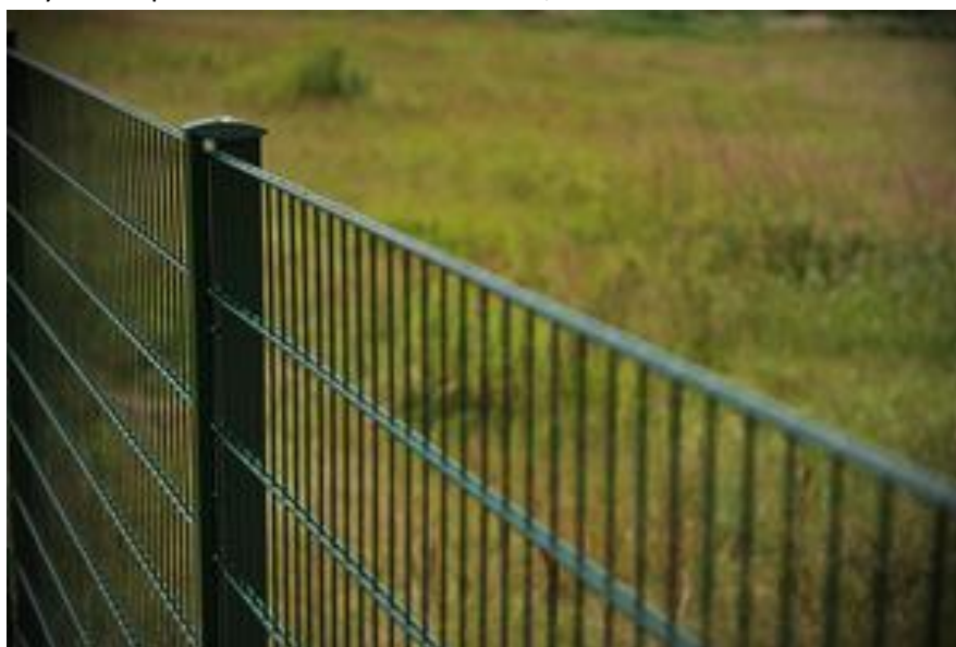
fot. 1 Sposób zakończenia panelu
